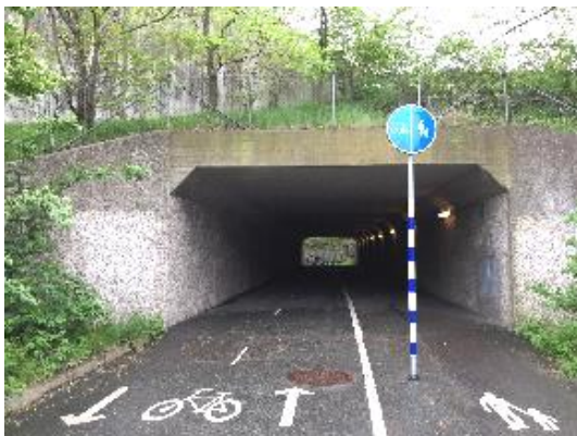
Gång- och cykeltunnel under E6 mot Skår
